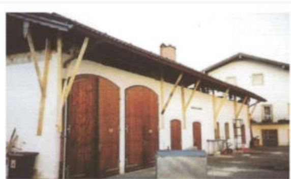
Anheben des Dachstuhles
